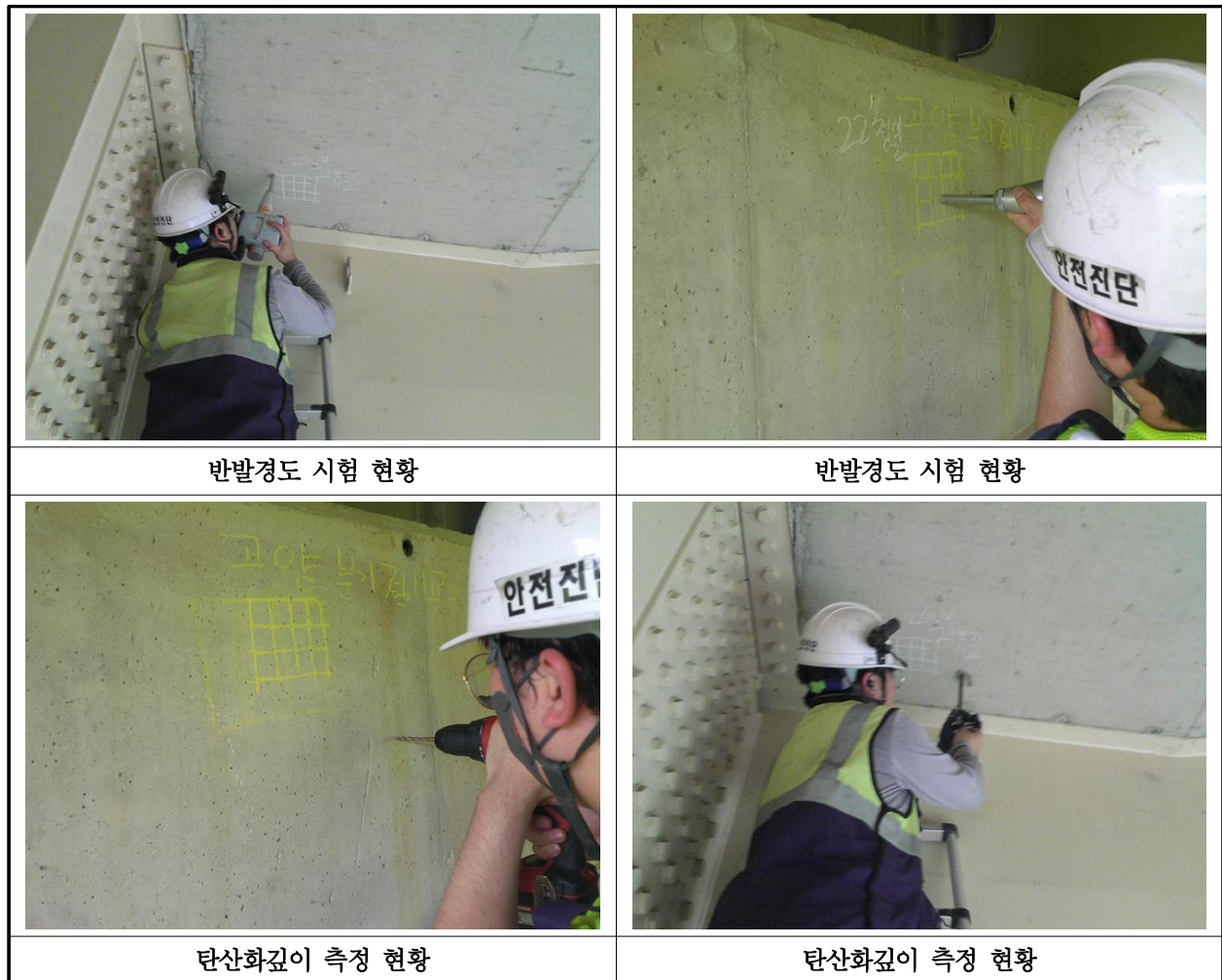
【사진 21.4.1】 콘크리트 내구성조사 현황
