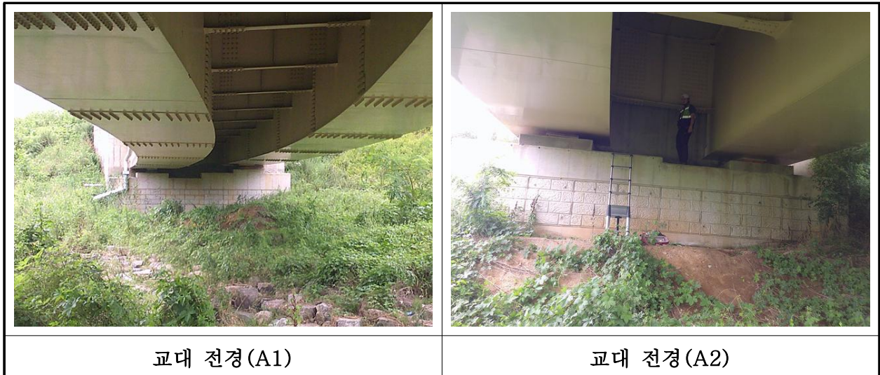
【사진 21.3.8】 교대 전경
