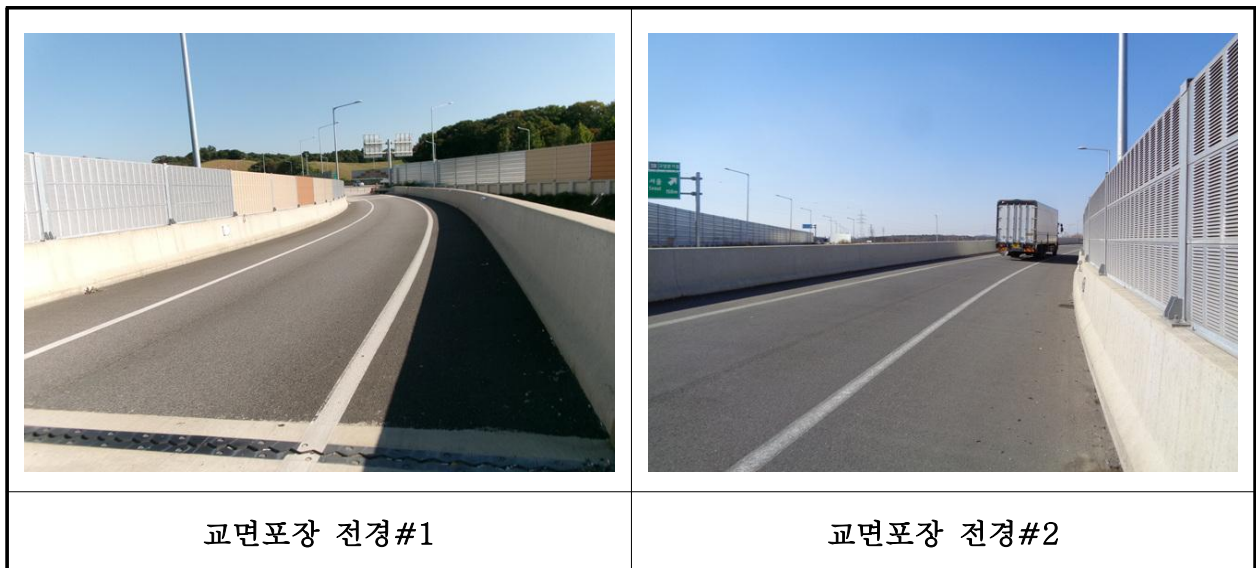
【사진 21.3.17】 교면포장 전경
