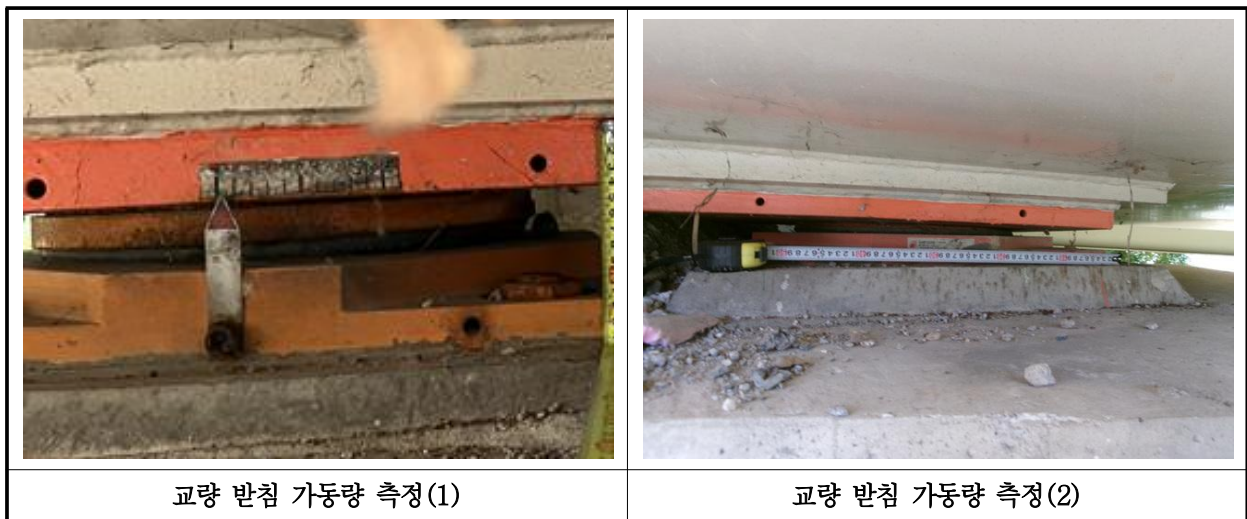
【사진 21.3.13】 교량받침 이동량 측정
