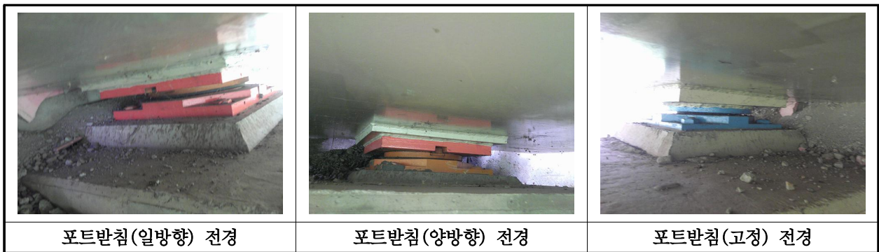
【사진 21.3.10】 교량받침 전경
