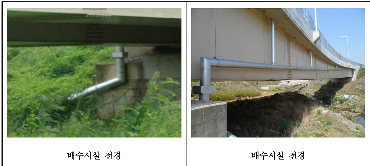
【사진 21.3.19】 배수시설 전경
