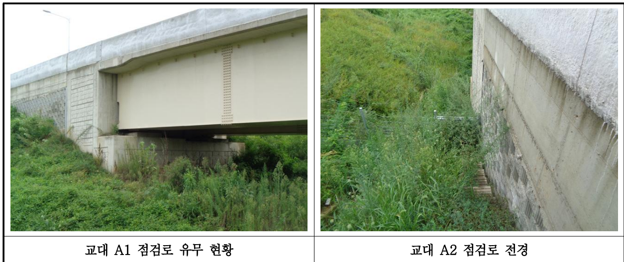
【사진 21.3.23】 교량 점검시설 전경
